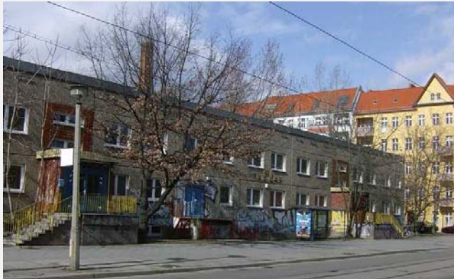
Straßenansicht vor der Sanierung und ...
